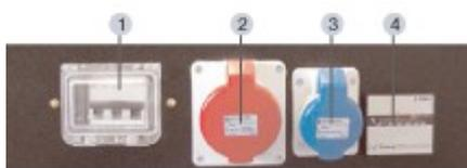
1. Автомат защиты от перегрузки и к.з.
